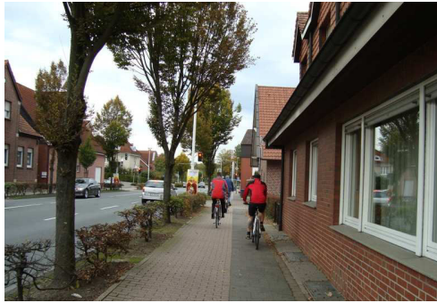
Schmale Seitenräume entlang der Daruper Straße
