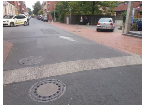
Teilaufpflasterung im Knotenpunktbereich (Hannover)
