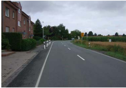
Havixbeckerstraße, Blick Richtung Nordwesten
