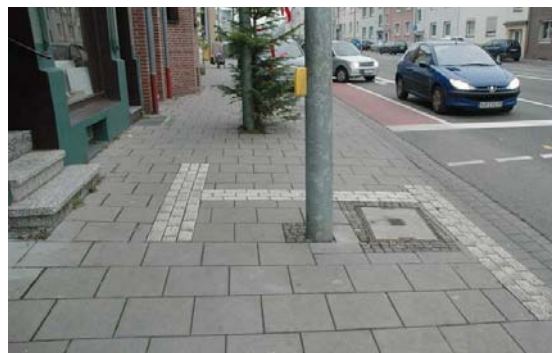
Taktile Leiteinrichtungen an einer Lichtsignalanlage
