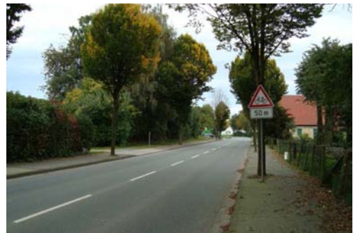
Gradliniger Straßenverlauf führt zu überhöhten Geschwindigkeiten
