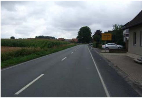
Havixbeckerstraße, Blick Richtung Südosten
