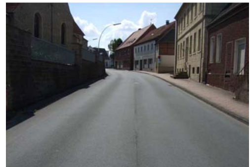
Coesfelder Straße auf Höhe der Kirche, Blick Richtung Westen
