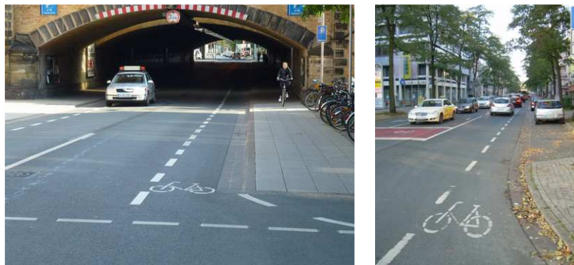
Einsatz von Schutzstreifen in Hannover (Königstraße)
