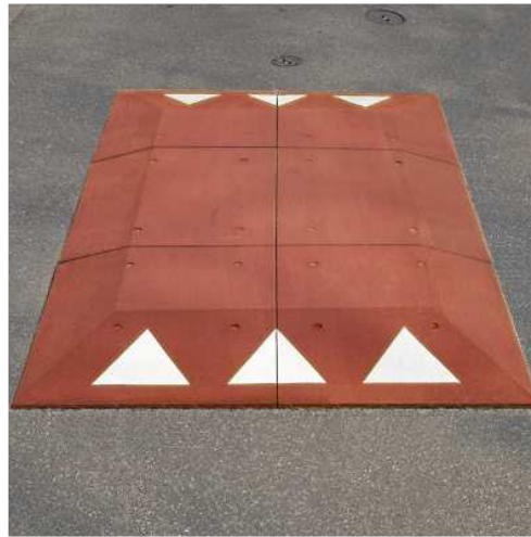
„Berliner Kissen“ provisorisch eingesetzt
