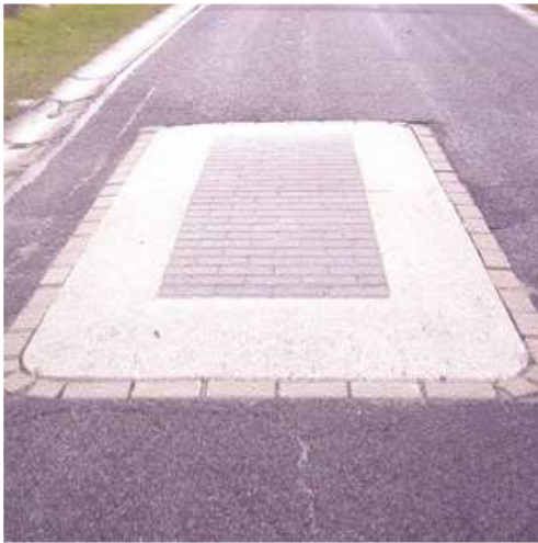
„Berliner Kissen“ baulich umgesetzt
